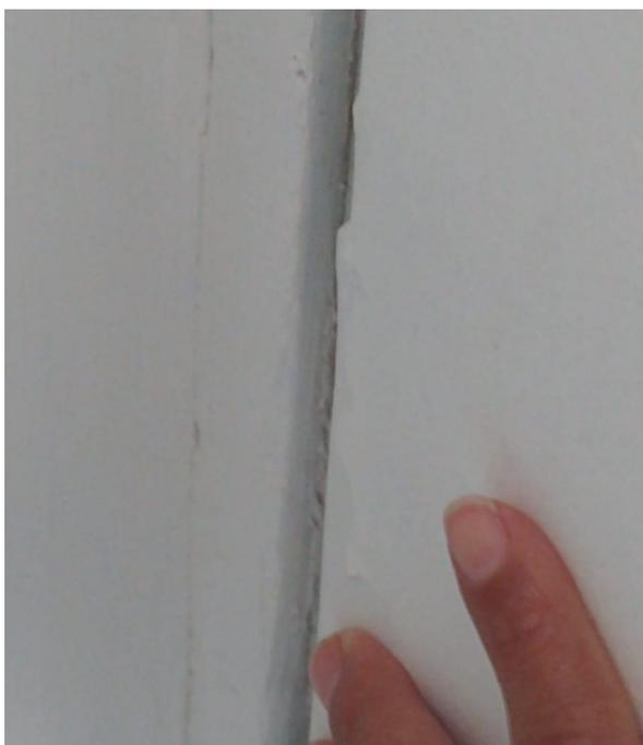
Grietas en la unión de la estructura con la mampostería
