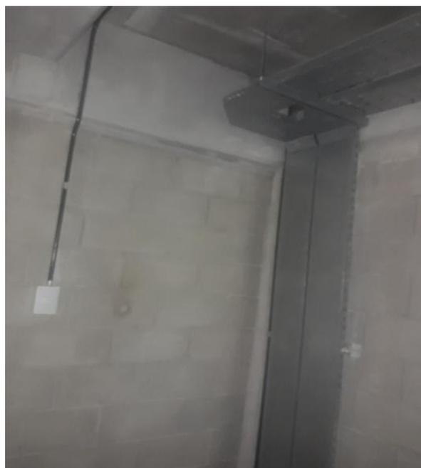
Conexiones eléctricas inseguras en paredes húmedas.
